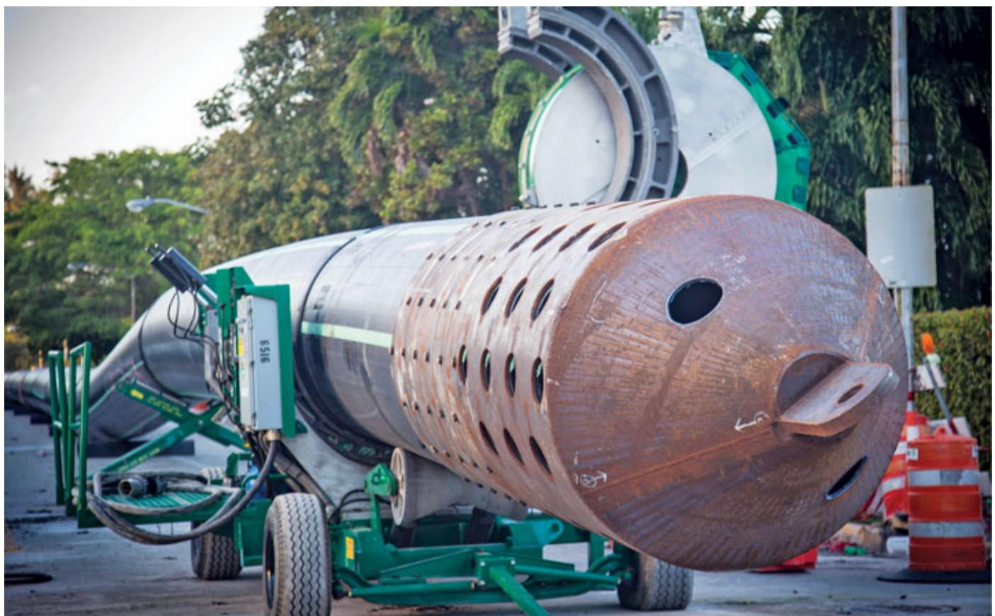
*O planejamento definiu que a extensa coluna seria puxada em dois segmentos, o primeiro denominado furo 1 com 788 m de extensão e o segundo denominado furo 2 com 544 m*
