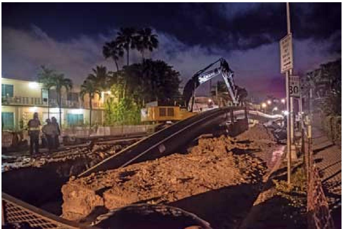
O PEAD comprovou ser uma solução para reabilitação de coletores principais de esgotos. Projetos como este, nos levam a transpor os limites do nosso conhecimento a respeito das capacidades e resistências dos materiais envolvidos. É uma realidade que ainda podemos ir mais adiante com tubulações plásticas.
